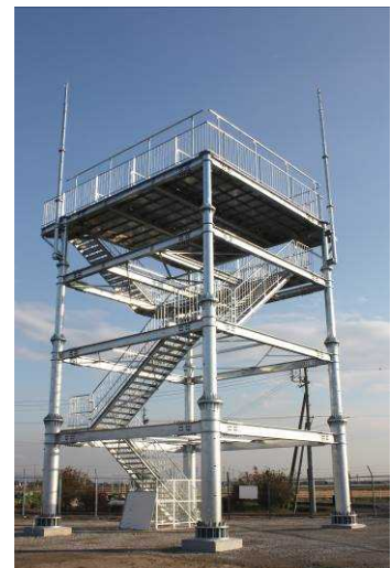
見学台（津波避難タワー）
