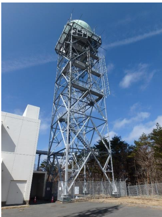
▲空中線鉄塔（No.2）補修工事完成写真
